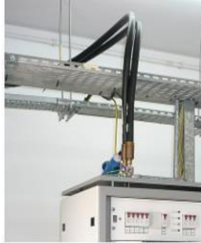
Şekil 113. Gelen anten devrelerinin korumaya ihtiyacı vardır.
