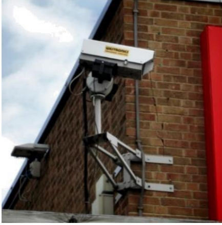
Şekil 15. Kötü tasarım ve yapıya sonradan yapılan eklemeler nedeniyle ayırma mesafesinin ihlali.
