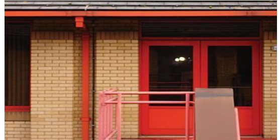
Şekil 54. Kötü konumlandırılmış bir iniş iletkeni örneği
