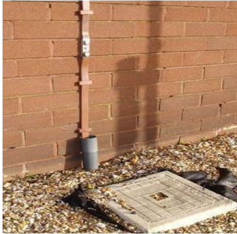
Şekil 51. Tipik iniş iletkeni konnektörleri.
