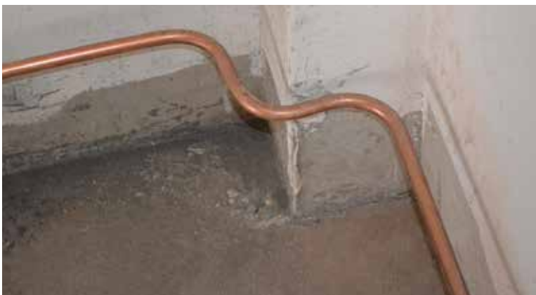
Equipotential grounding conductor
